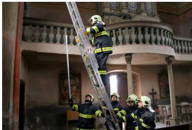
Ve zbyslavském kostele bylo třeba odstranit nebezpečné nánosy sutí z vnitřní římsy.
